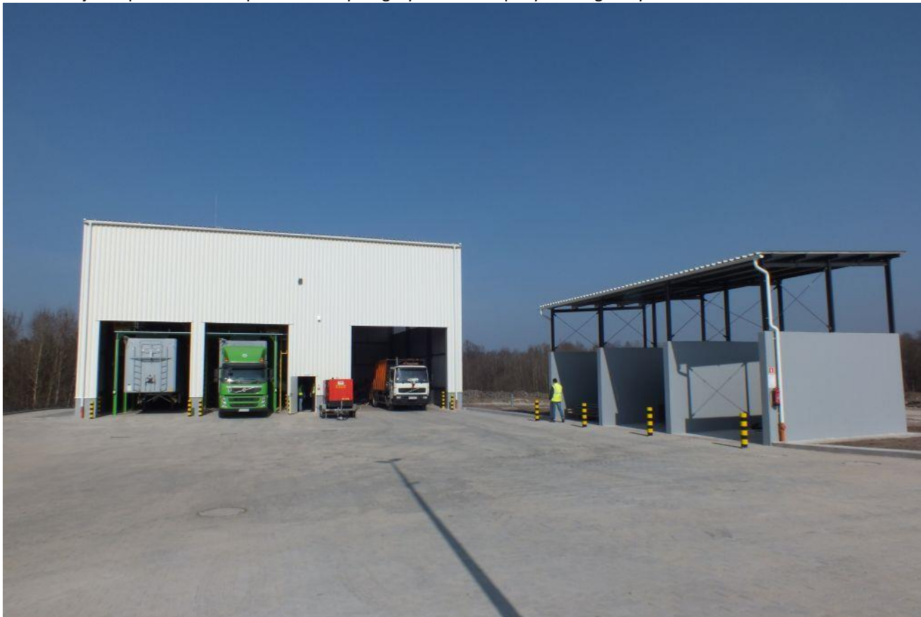
1. Od lewej hala przeładunku odpadów i boksy magazynowe na odpady wielkogabarytowe
