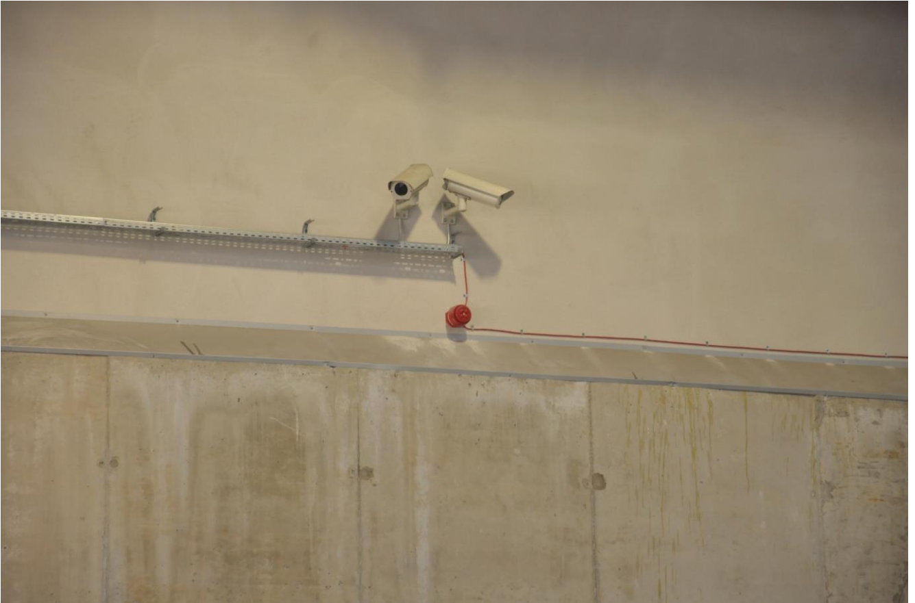
8. Hala do załadunku odpadów 2
