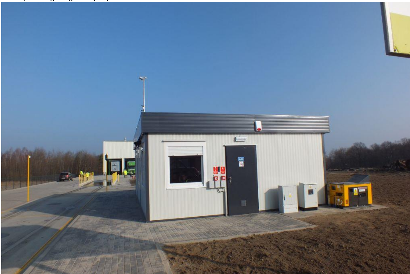
2. Budynek wagowego i socjalny
