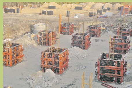
Zbrojenie fundamentów pod budynki hali wiaty, Stacja Przeladunkowa w Lubsku
